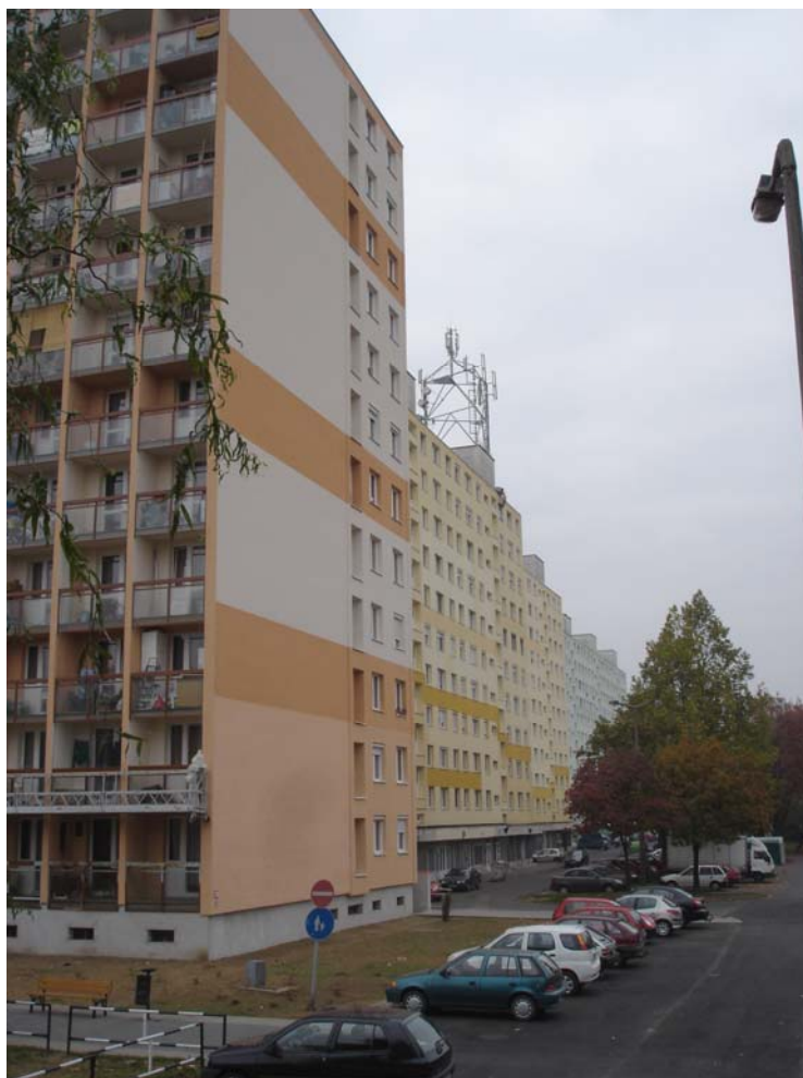
35. kép: A panel-programból felújított energiatakarékos épület az Ungvár sétányon
